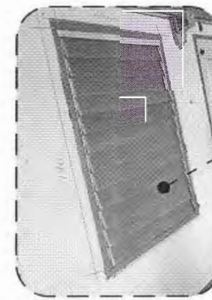
② - รื้อถอนบานเกร็ดพร้อมเปลี่ยนเป็นบานช่องแสงติดตาย *จำนวนทั้งหมด 6 ชุด*
