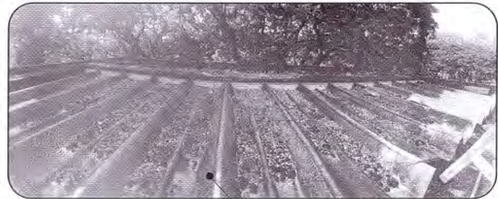
รีดถอนหลังคาเดิม พร้อมติดตั้ง จันทัน แป แผ่นหลังคาเมทัลชีทใหม่
