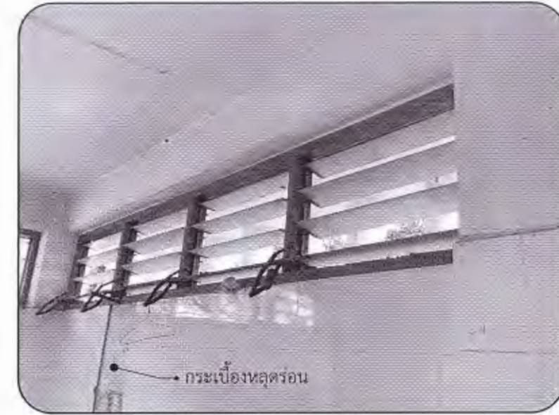
ภาพประกอบแสดงความเสียหายของกระเบื้องผนังห้องน้ำบางส่วน
